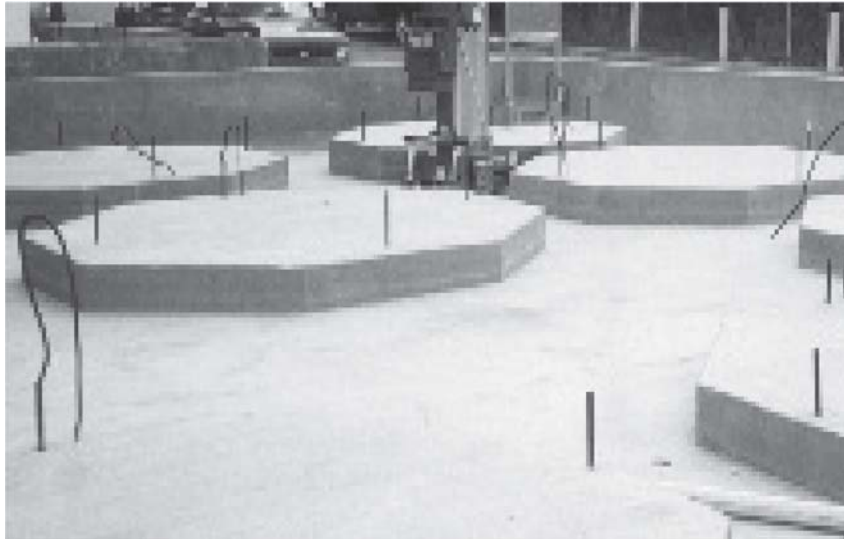
รูปที่ 3-13 การป้องกันกรณีเกิดสารหกรั่วไหล
